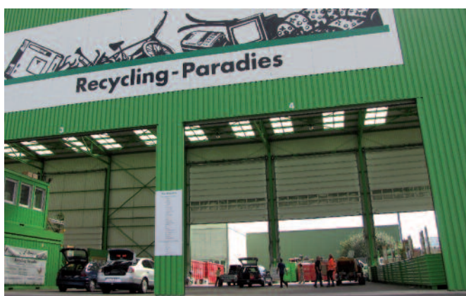
Komfortable Platzsituation dank grosszügigen Einfahrtstoren.
